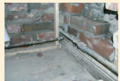
Statische Stahl-Hilfskonstruktion zur größeren, besseren Lastübertragungsverteilung des GEWI-Spannankers auf das Mauerwerk.
