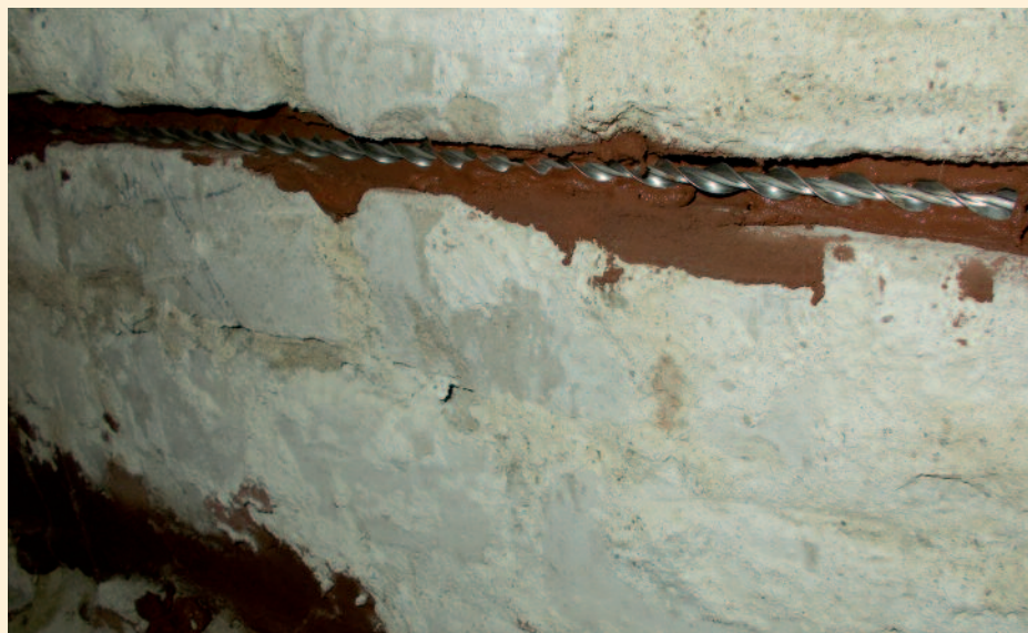
Horizontaler Spiralanker mit speziellem Ankermörtel im System.
