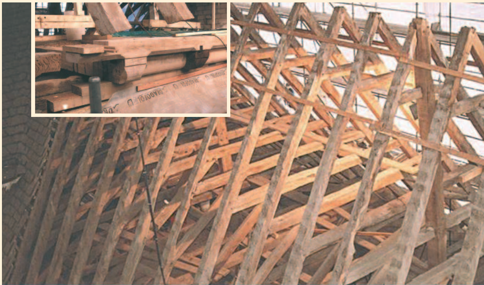
Dachstuhlrestaurierung im Kloster Marienmünster.
