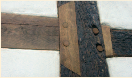
Fachgerecht ausgeführte Fachwerkreparatur.
