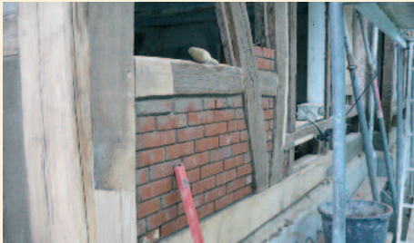
Neue Gefachhausmauerung mit weichgebrannten Westfalen- Backsteinen, mit Trasskalkmörtel vermauert.
