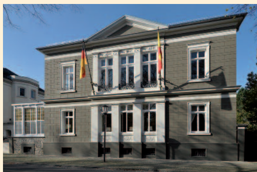
Detmold, Villa Verein Ressource. Komplette Fassadensanierung.
