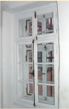
Rekonstruktion eines Innenvorfenster als Kastenfenster.
