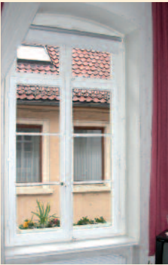
Rekonstruktion eines Innenvorfenster als Kastenfenster.
