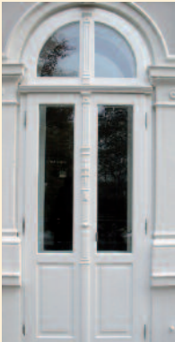
Rekonstruktion einer isolierverglasten Balkontür.
