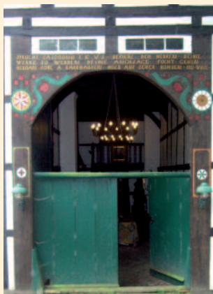
Neu angefertigtes Deelentor nach historischer Vorlage.
