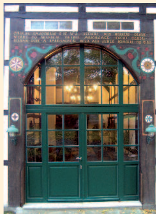
Neu angefertigtes Deelentor nach historischer Vorlage.
