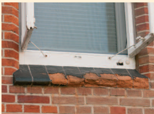
Historische, glasierte Ziegelsteine, teilweise restauriert, instandgesetzt und durch neue, brandglasierte Ziegel ersetzt.
