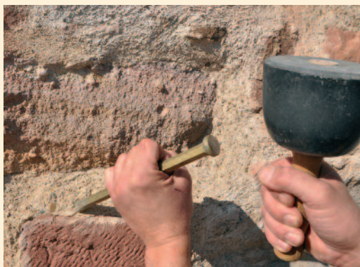
Handwerkliche Steinmetzbearbeitung am Fugenwerk und Scharrierungen der Sandsteinoberflächen.
