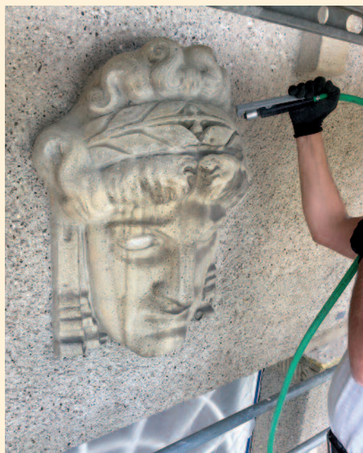
Substanzschonende Reinigung im Microstrahlverfahren.
