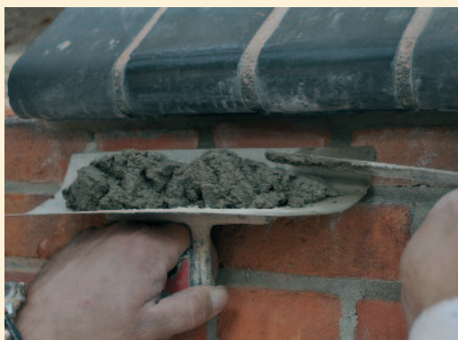
Ergänzungen und teilweise Erneuerungen der historischen Verfugung an der Ziegelfassade.
